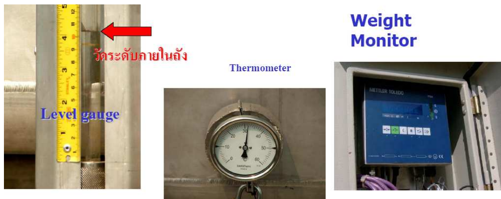
ภาพที่ 4 มาตรฐานวัดปริมาณสารเคมี Acetic anhydride ภายใน Storage Tank
